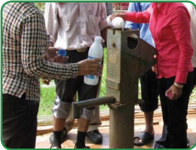
៣ ចាក់ទឹកក្តារចំនួន២ដបចូលក្នុងអណ្តូង (១ដប=៦០០មល)
